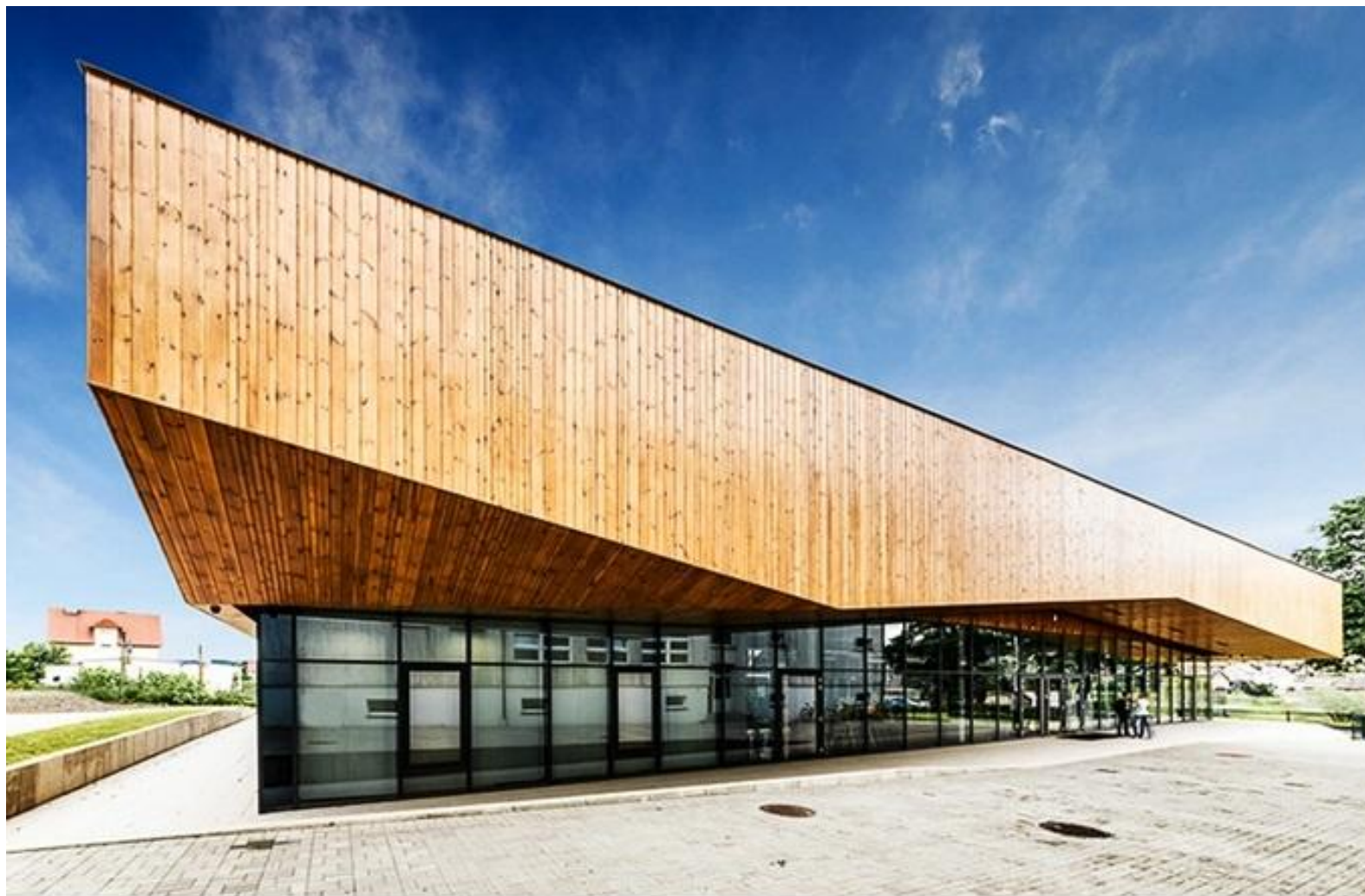
Gminna Biblioteka Publiczna w Czarnym Borze, projekt: ISBA Grupa Projektowa, inwestor: Gminna Biblioteka Publiczna w Czarnym Borze, 2011-2012, fot. http://isba.com.pl
